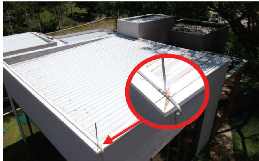
Figura 2 – Corrosão nas conexões (Arquivo do autor)
